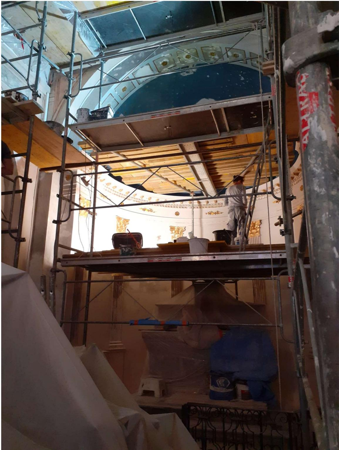
Les restaurateurs de l'atelier Jouve-Malfatto d'Etoile sur-Rhône ont consolidé les fissures et défauts des murs par injection de résine. Ils ont pu alors enduire les murs intérieurs à la chaux.
